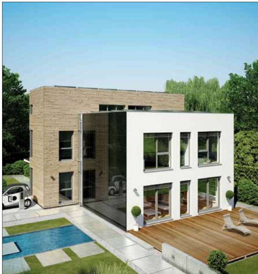
Die Photovoltaikanlage ist in die Fassade integriert.
